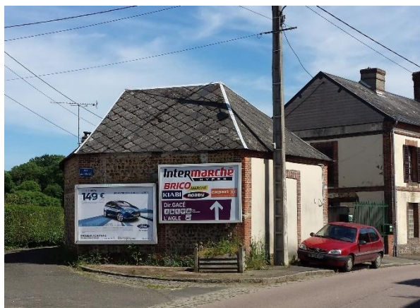
Panneaux imposants et impact sur l'alignement bâti - Glos-La-Ferrière Source : EVEN Conseil
