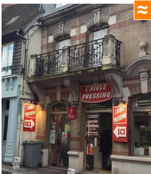
De nombreuses enseignes impactant la façade d'intérêt architectural – L'Aigle Source : EVEN Conseil
