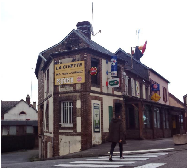
Une certaine densité d'enseigne en façade pour une même activité, notamment perpendiculaires, pouvant dégrader la façade architecturale - L'Aigle Source : EVEN Conseil
