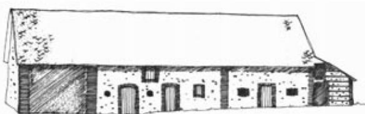
Bâtiment agricole de structure mixte brique et silex.
